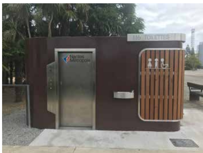
Nantes Parc Chantiers L200 SPE
