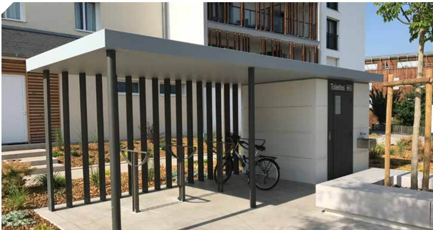
Montlouis-sur-Loire toilette PMR avec abris vélos
