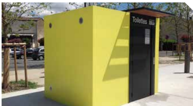
Toiture terrasse : marquise
