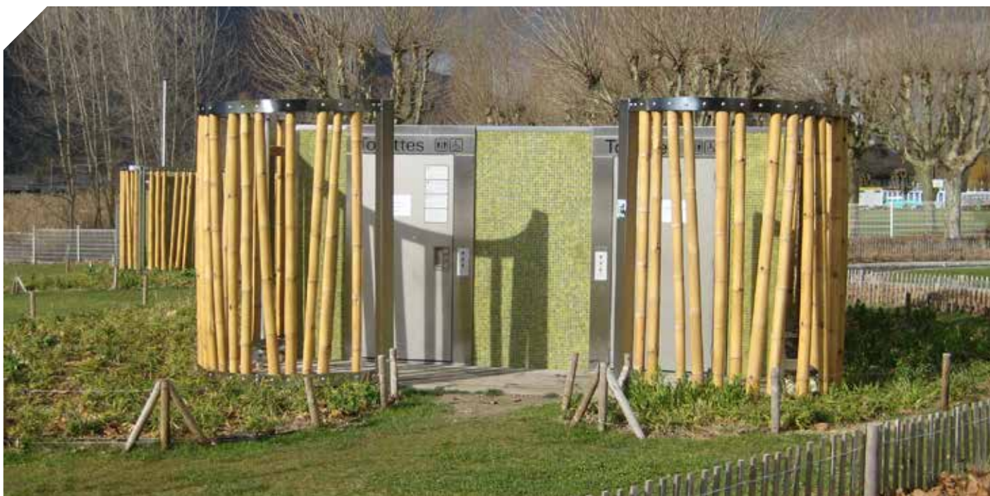
Parc Rowing Annecy, 2 toilettes PMR et douches extérieures
