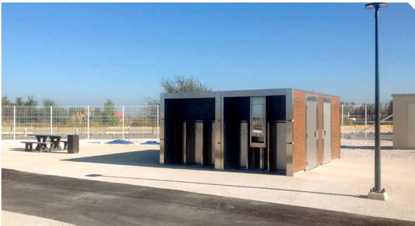
Port Autonome de Marseille 1 toilette PMR, 1 Toilette DM, lave-mains et bac de lavage extérieurs, 5 urinoirs extérieurs, 1 douche PMR et 1 douche DM
